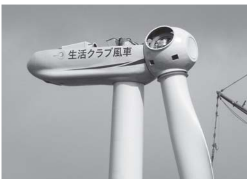
建設中の風車(2012年2月)
